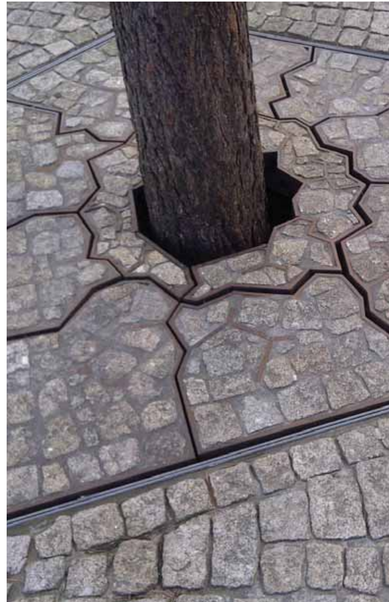
Afb 4.12 Een 2e maaiveld verzorgt in draagkracht en wortelruimte in Apeldoorn
