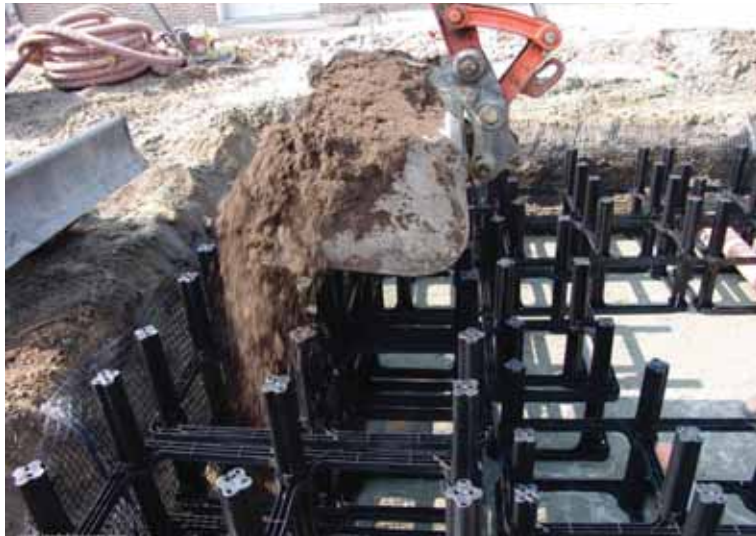
Afb 4.10 Dit systeem van kunststof heeft een matige draagkracht
