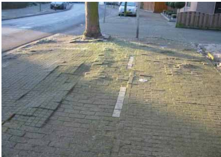
Afb 4.5 Te weinig wortelruimte resulteert in de opdruk van verharding
