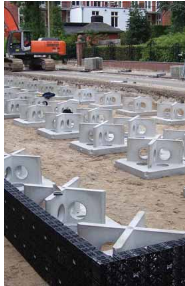
Afb 4.6 Ondergrondse groeivoorziening t.b.v. de doorwortelbare ruimte
