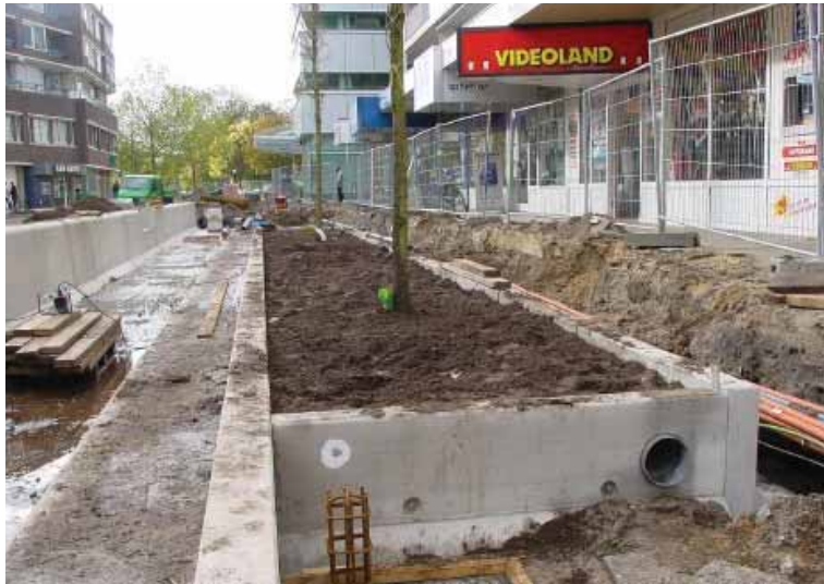
Afb 4.13 Betonconstructie naast waterloop en voetpad in Apeldoorn
